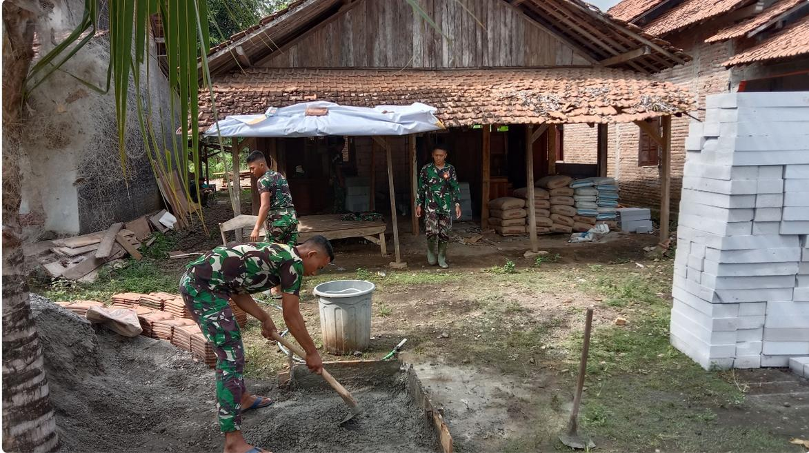
"Material bata ringan atau sering disebut hebel yang terbuat dari campuran pasir silika, gypsum, batu kapur dan semen yang terkenal kuat dan ringan untuk membuat bangunan, kemudian dalam pemasangan hebel terlihat cukup mudah dan cepat tidak menggunakan adonan pasir semen," ujarnya.
